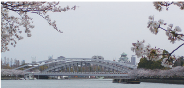
写真1 桁架設完成時写真（写真手前が新桜宮橋、奥が銀橋）
