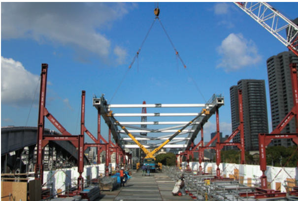
写真3 アーチリブペントとアーチリブ架設状況
