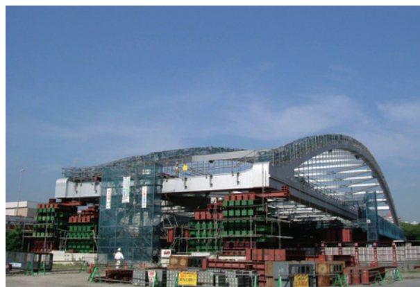
写真5 降下作業状況
