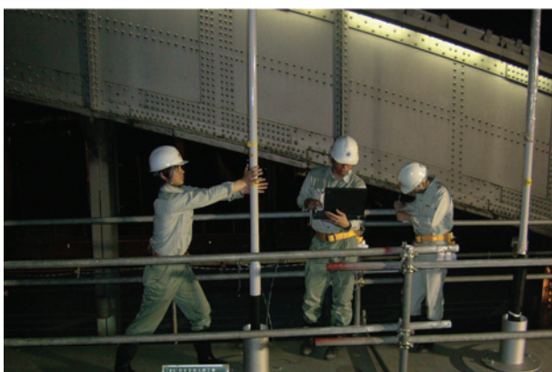
写真6 ケーブル張力測定状況
